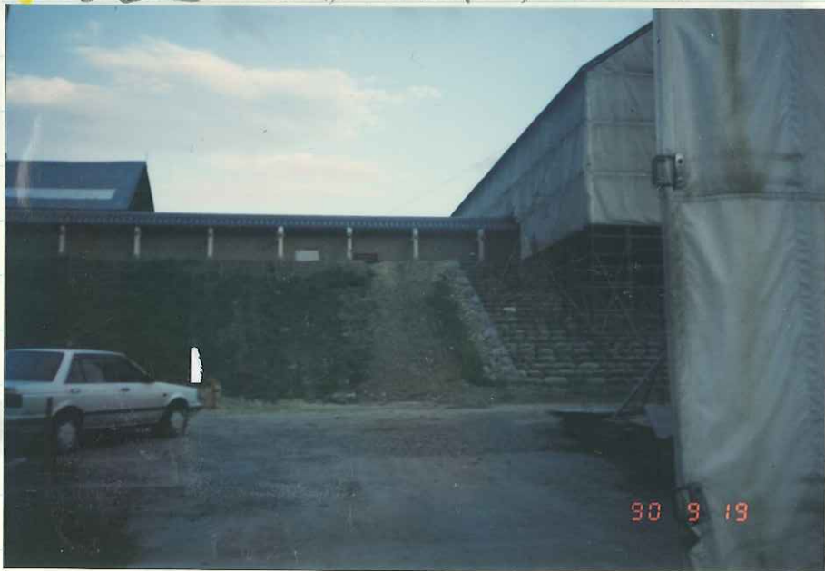
★ ニノ丸 かくげん工事
