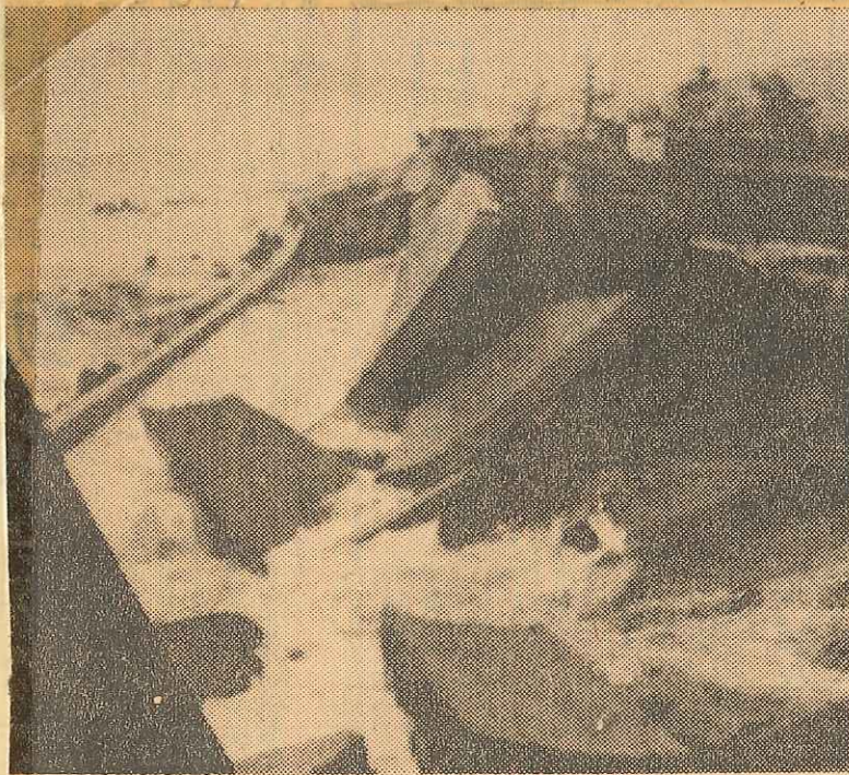
台風23号で決壊した高知県土佐市新居の堤防
